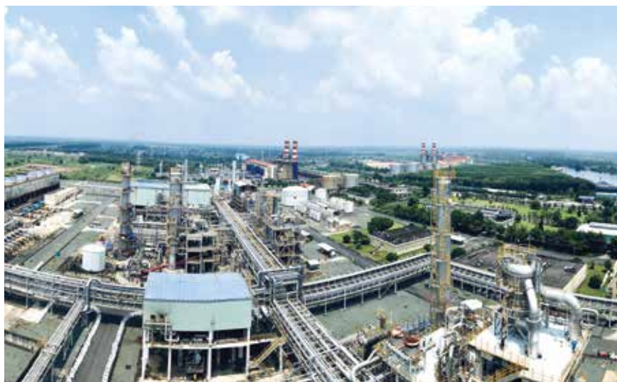
Nhà máy Đạm Cà Mau. Ảnh: PVCFC
